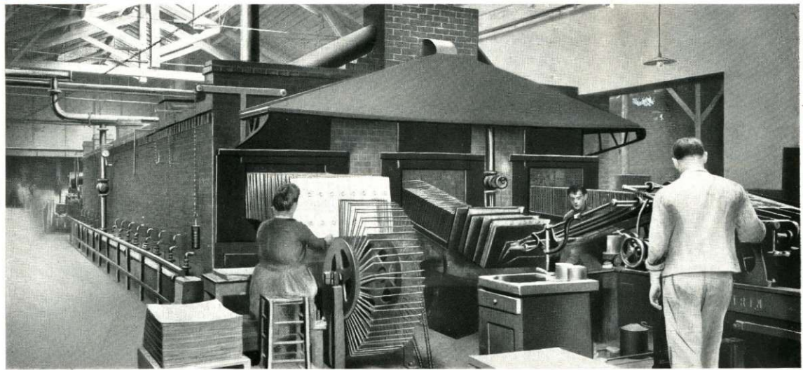
Fig. 7 — Four continu à Gaz PIERSON pour la cuisson du fer blanc imprimé (fabrication de la boîte métallique, Établissements J.-J. Carnaud et Forges de Basse-Indre, Usine de Billancourt).
